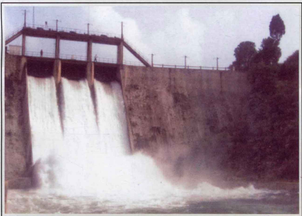
黔西县附廓水库大坝
