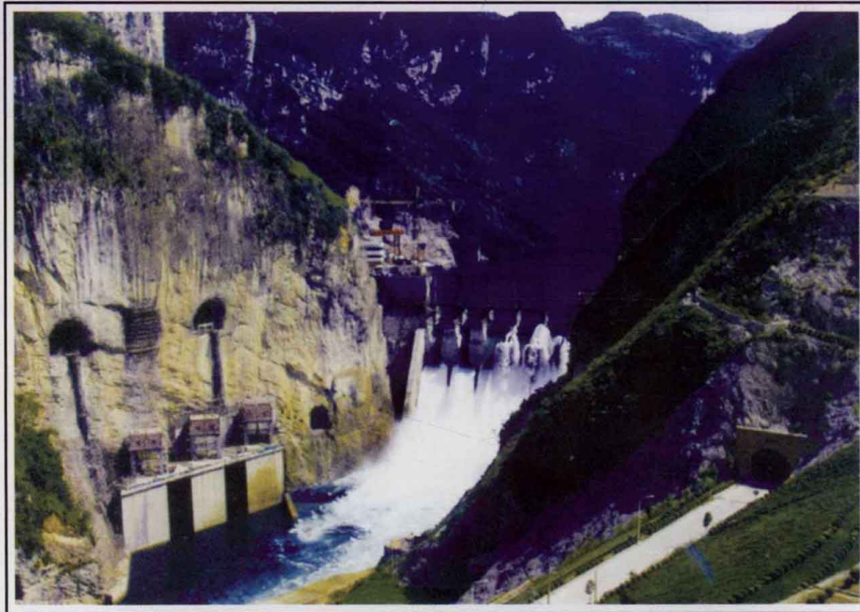
索风营水电站大坝
