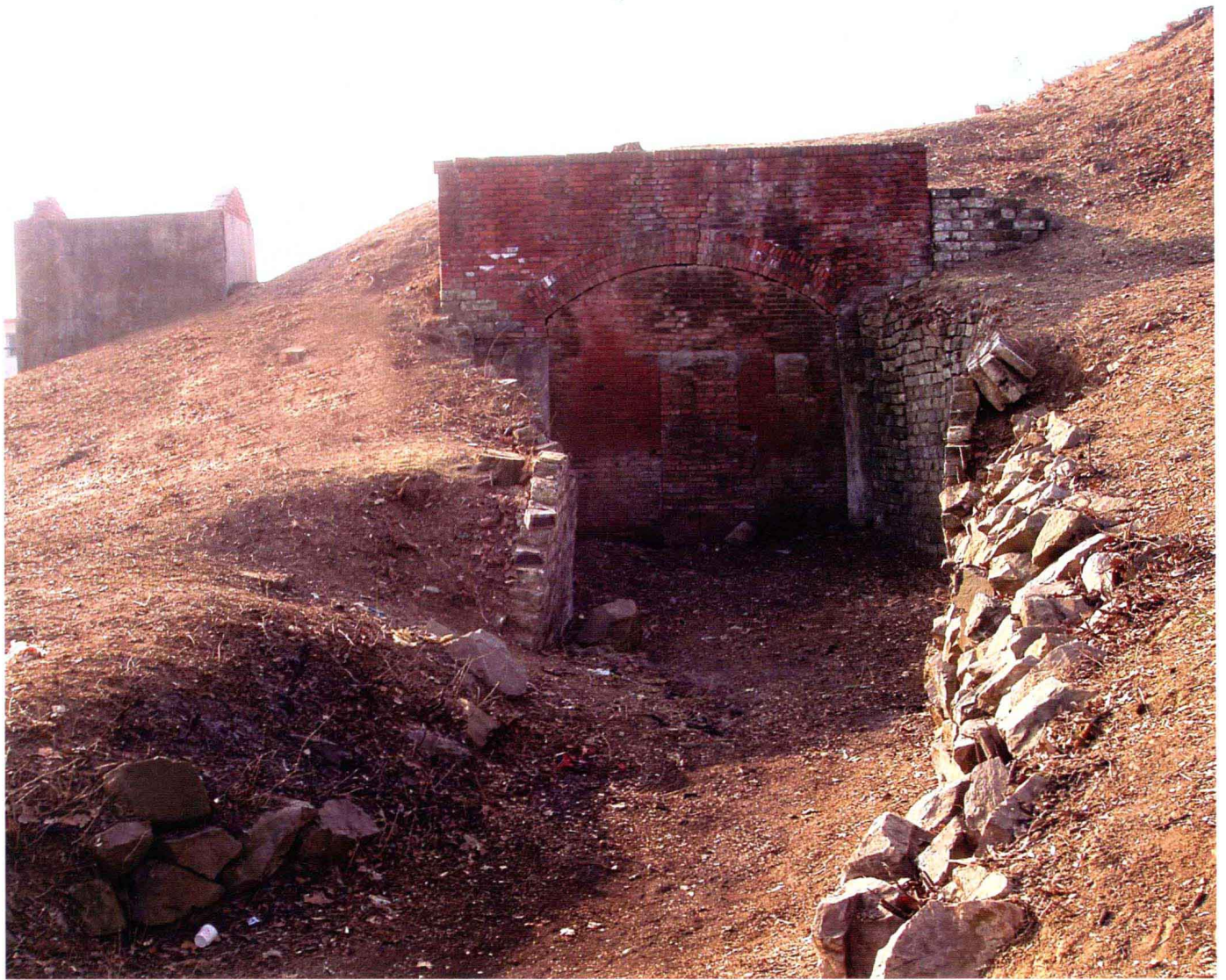
3. 一号墓封土内防空库房北大门
