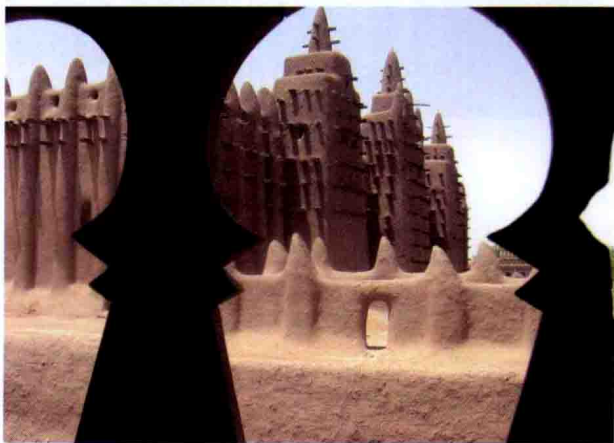
图 1-21 苏丹杰内古城。用灰泥涂抹的捣实粘土块是当地这些气候干旱国家的常用的建筑构造方式
