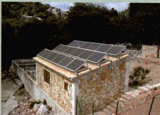
▲ 太阳能污水厂
