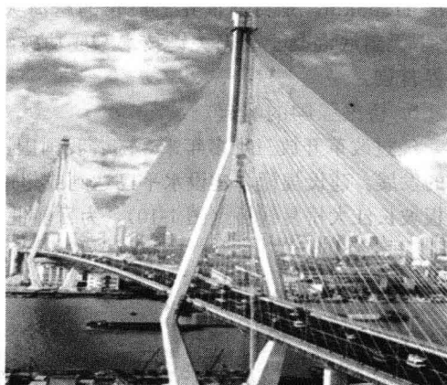
图 1-6 上海杨浦大桥
