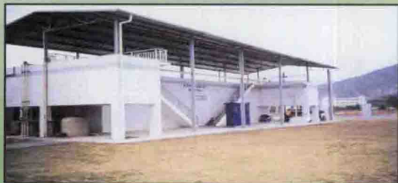
康佳集团线路板厂生产废水处理站
