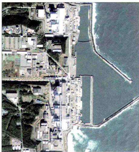
02—1 福岛核电站卫星图，下半图自上往下是 1、2、3、4 号机组，上半图自上往下是 6、5 号机组。由于地震和海啸，使冷却系统停止运作，导致 1、2、3 号反应炉过热、堆芯熔毁，造成放射性物质外泄。
