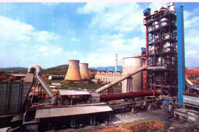
梅州市塔牌集团150万吨旋窑及火力发电设备(古礼贤摄)
