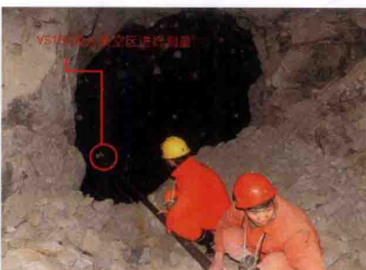
扫描现场，保障测量人员安全
