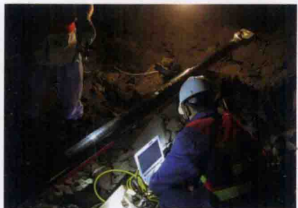
扫描现场，保障人员安全同时，快速高效的完成采场扫描
