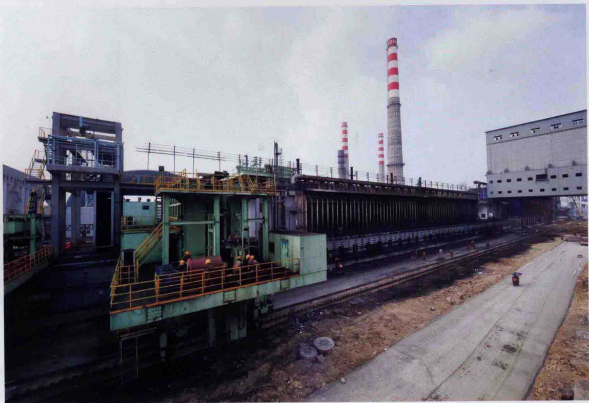
首钢国际工程公司设计的川威年产140万吨6m捣固式焦炉
