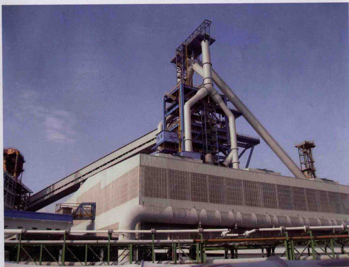
首钢国际工程公司设计的首钢迁钢4000m 3 高炉
