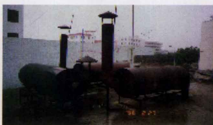
柴油发电机排烟管增设阻扩式消音器
