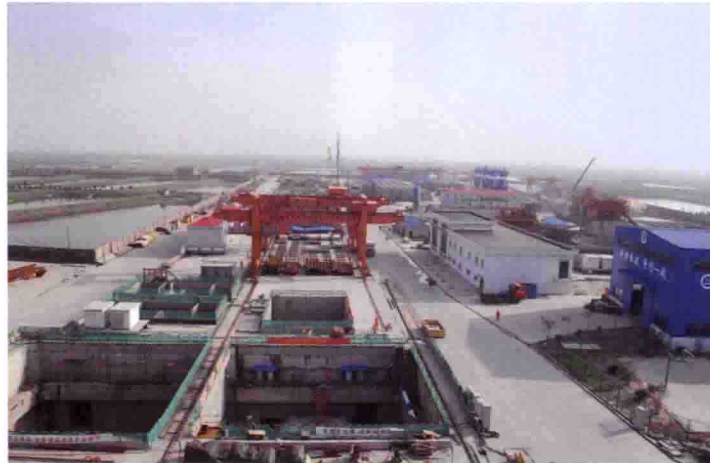
钱江隧道工地全景
