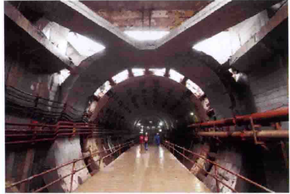
钱江隧道内部施工
