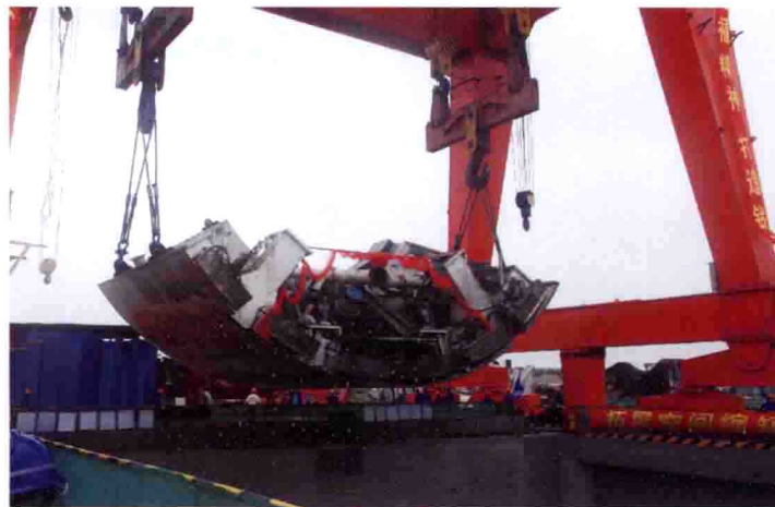
钱江隧道盾构机吊装
