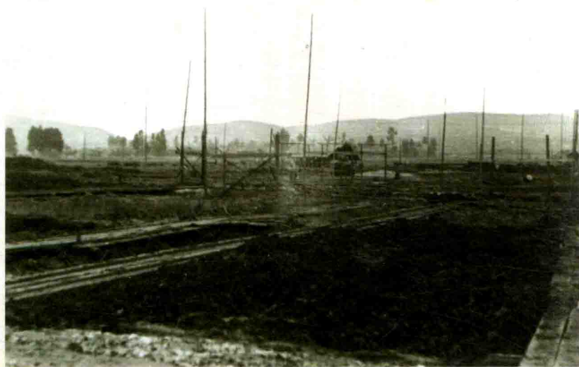
建设中的电解车间场地
