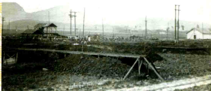
1958年正在建设中的熔炼车间场地
