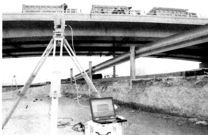
图 1-1 桥梁鉴定验收荷载试验
