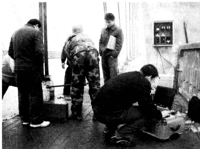
图 1-6 斜拉桥索力的动力法现场检测
