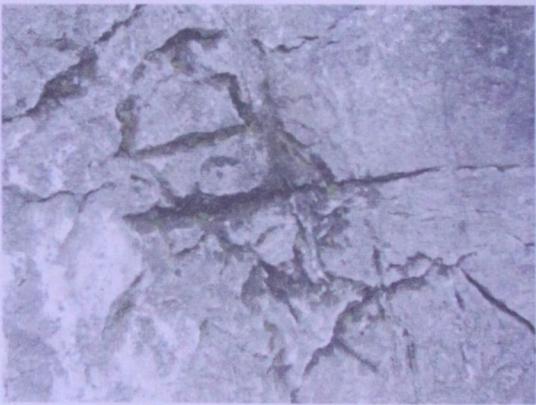
图 1-1-7 岩石表面的裂隙
