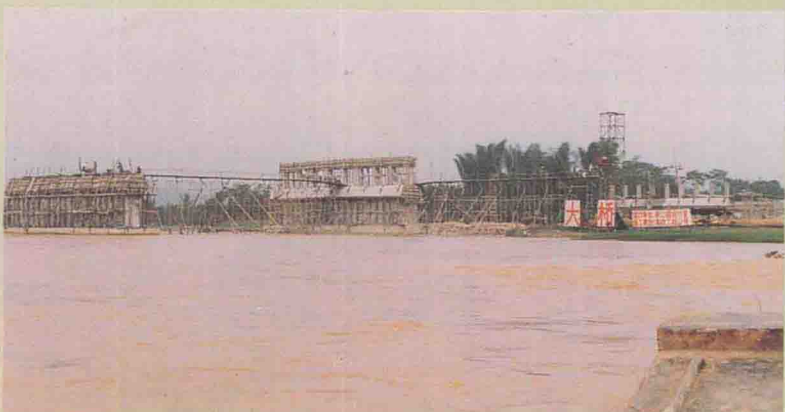
正在施工的梅州大桥
