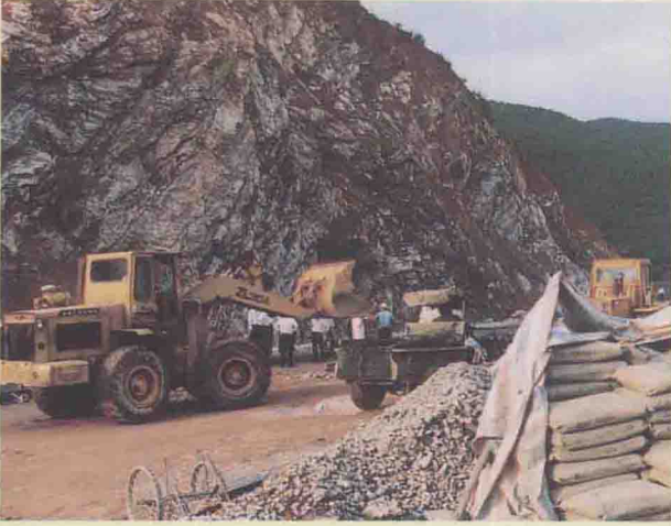
国道改造施工现场
