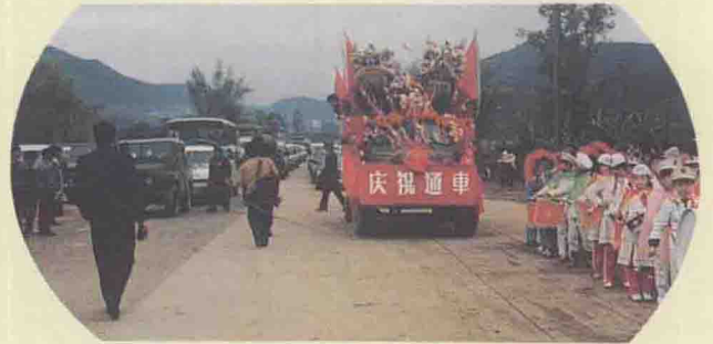
205 国道蕉岭段率先竣工
