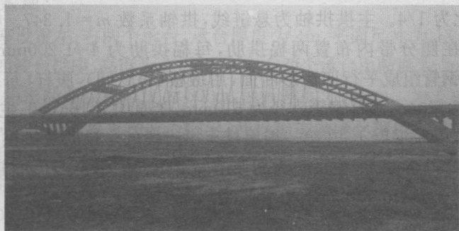
图 2-1 滹沱河大桥主桥
