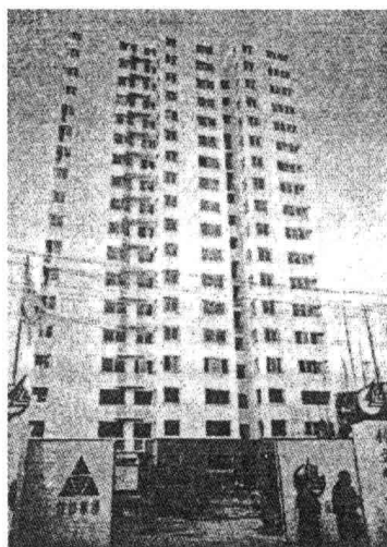
图 1-9 上海园南四街坊 18 层住宅
