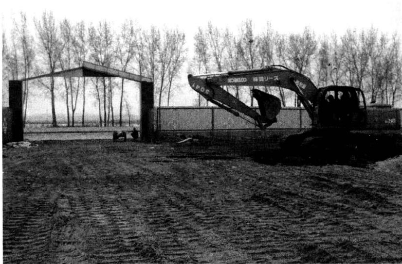
图 1.1 施工准备阶段场地平整
