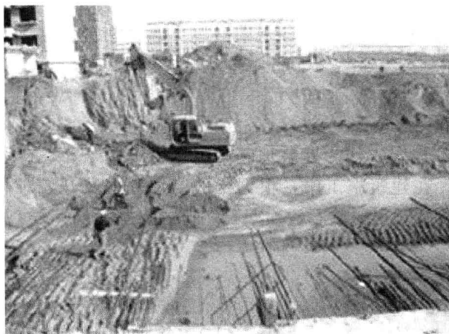
图 2.1 土石方施工工程实例
