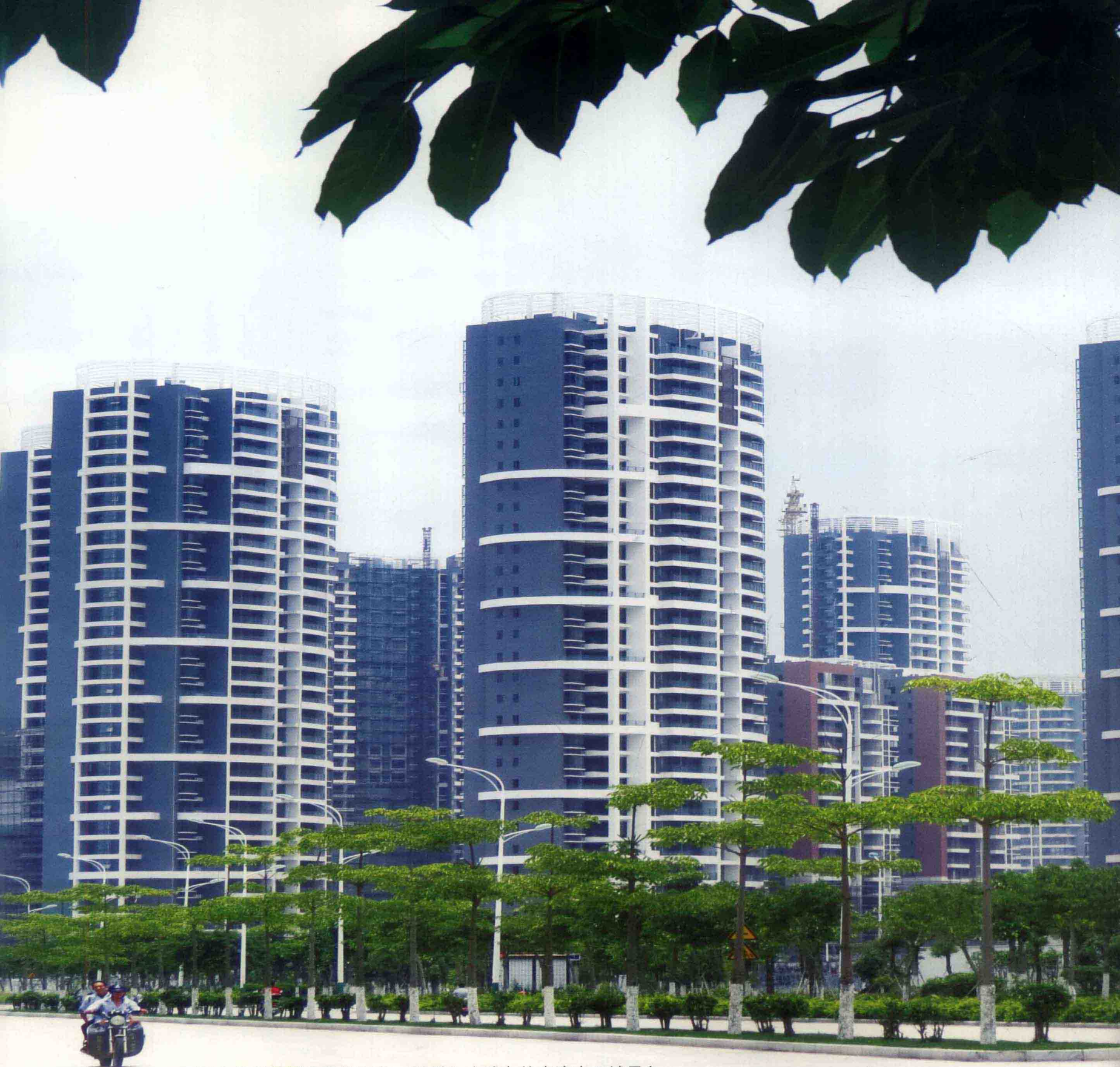
雨后春笋般的楼房拔地而起。被誉为小浦东的杏滨中亚城景色。
