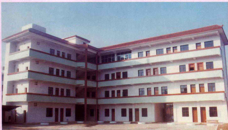
▲ 1968年盈江县人民政府林业局新建 四层钢混平顶办公楼房。
