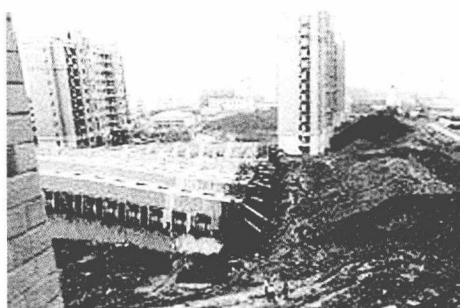
图 1-2 上海的一处高楼因桩基破坏倒覆
