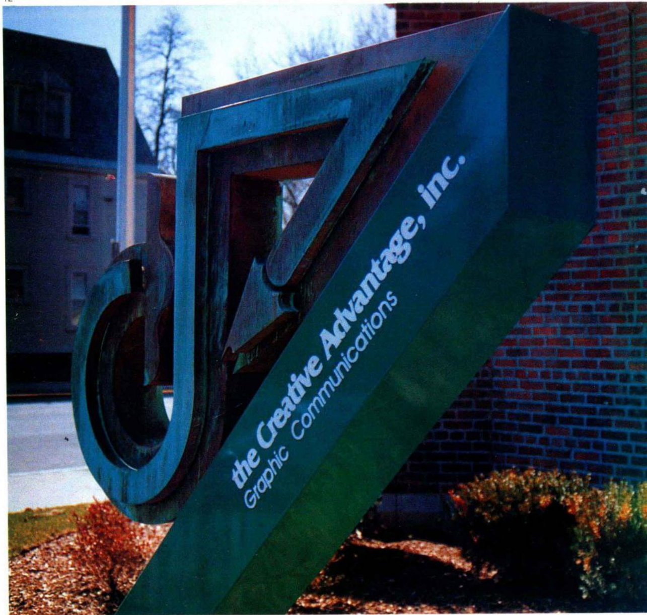
这个设计公司 2 米高的单面标识招牌用铜片制作，悬空的部分由白色霓虹灯照明。底座部分由铝材料制作，内部有支撑铝角架。文字由计算机刻字，白色丙烯酸字母由两个高功率荧光灯照明。
