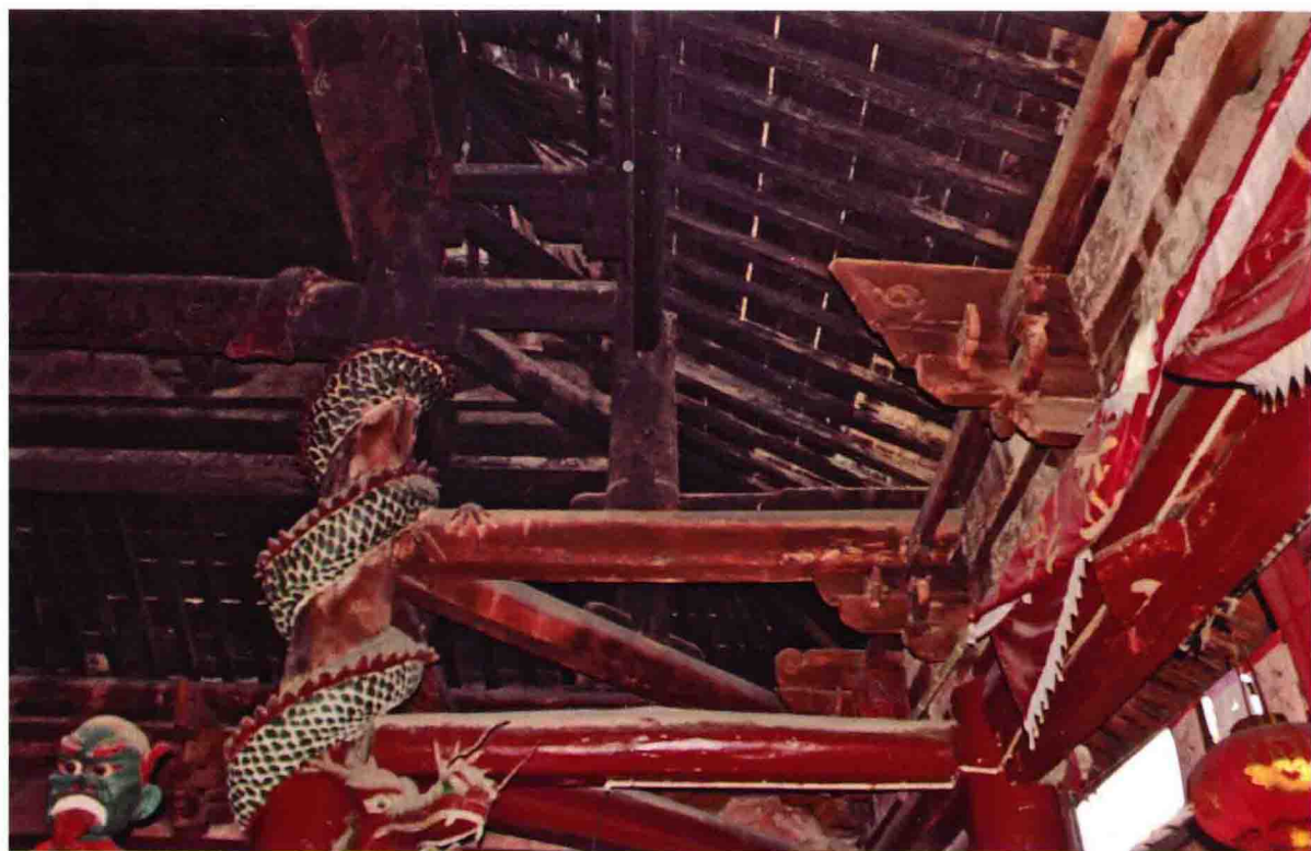
岱岳殿梁架结构
