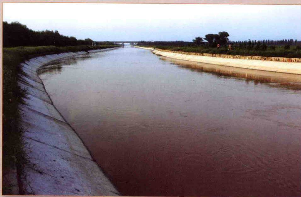
人民胜利渠输水渠道
