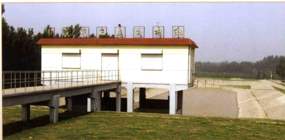
连接山东、河北两省输水、接水的骨干工程——引黄穿卫枢纽工程
