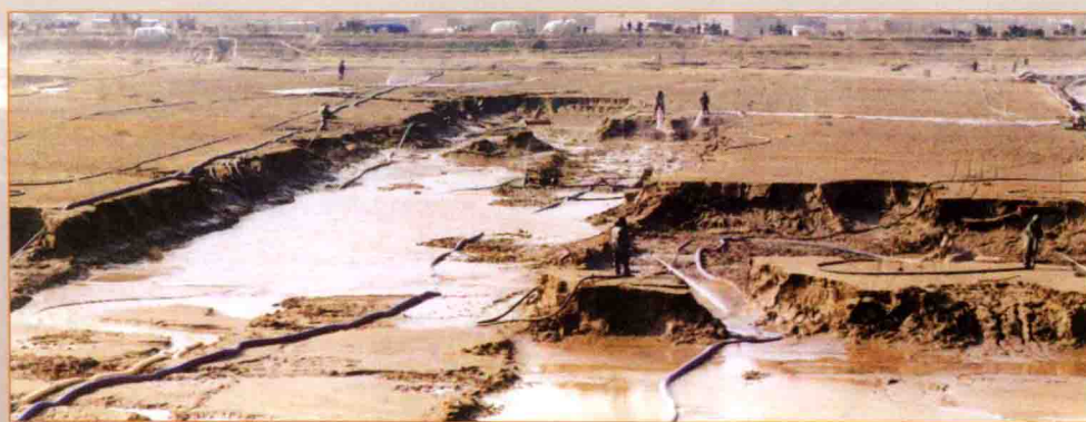
位山灌区沉沙池清淤施工
