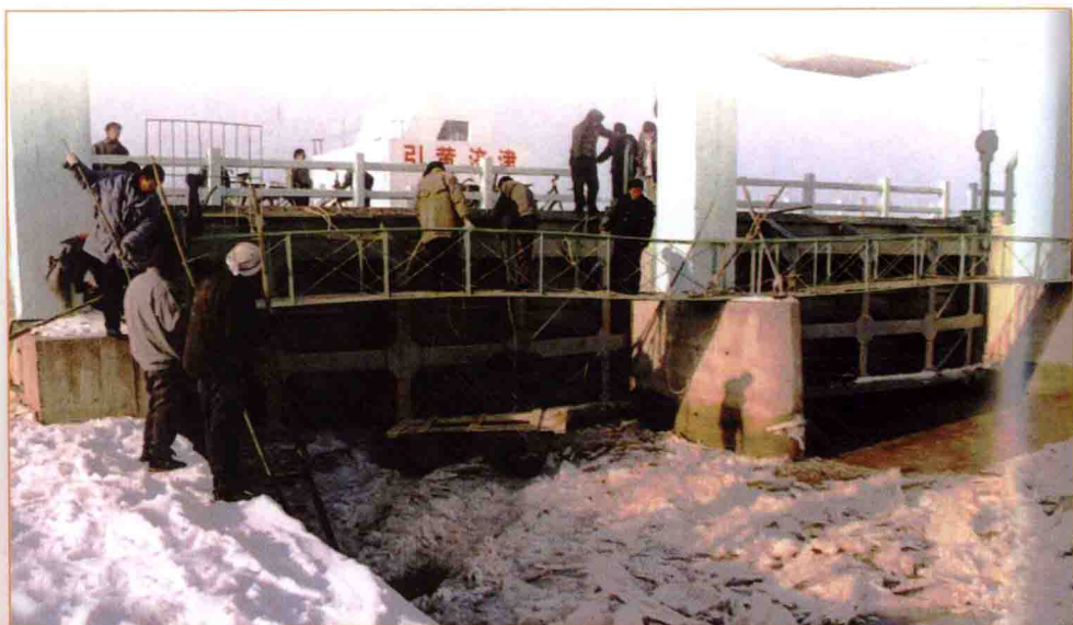
跨冬季输水，严重的河道冰情是一大挑战，上图为人工破冰作业
