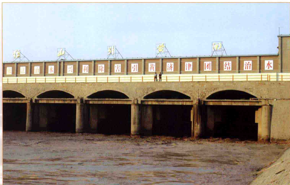
位临三千引黄济津线路位山渠首闸
