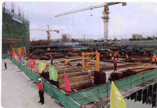
建设工地（字应军/摄）
