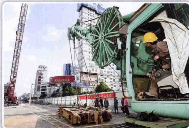
2010年5月3日，北京路交三桥路口，自重50吨的800成槽机正在试机。经过前期的准备，各类大型施工机械开始陆续进场 (王俊星 摄)
