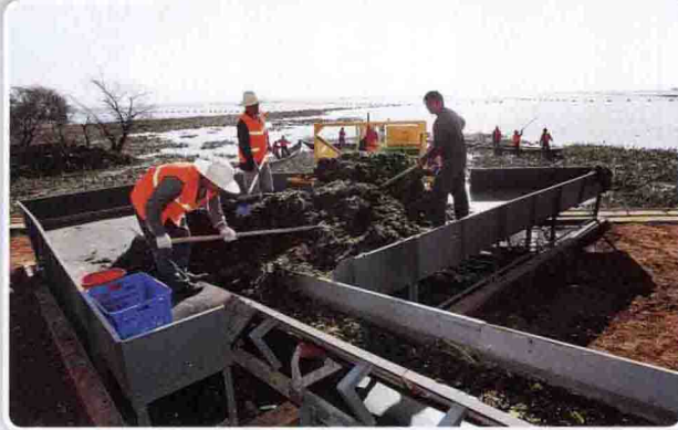
2010年2月2日，工人将粉碎后的水葫芦输送到加工处理场地挤压、发酵 （王俊星 摄）
