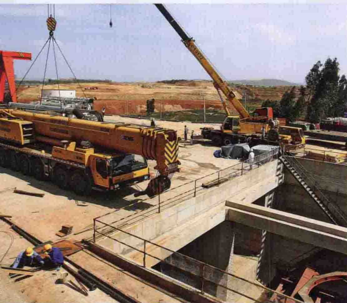
“春城5号”盾构机分别由12辆汽车陆续运送到小王家营站——呈贡北站，吊装入隧道基坑
