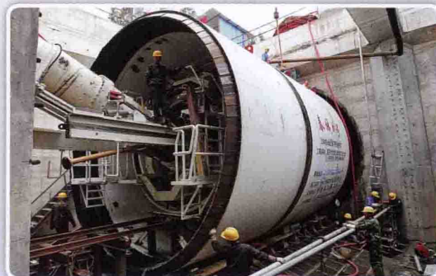
“春城6号”盾构机吊装完毕准备始发 (谢慧 摄)
