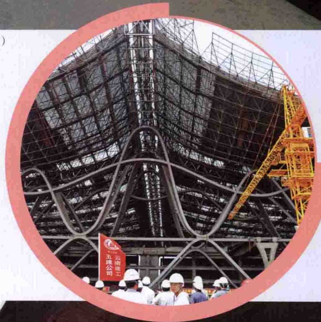
2010年5月29日，国务院安委会第七督查组检查昆明新机场建设工程 (杨艳辉 摄)
