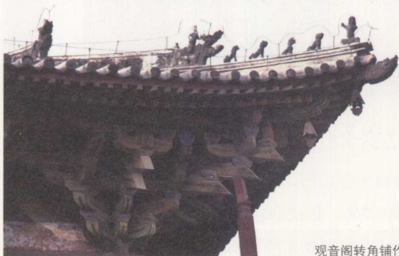
观音阁转角铺作斗拱
