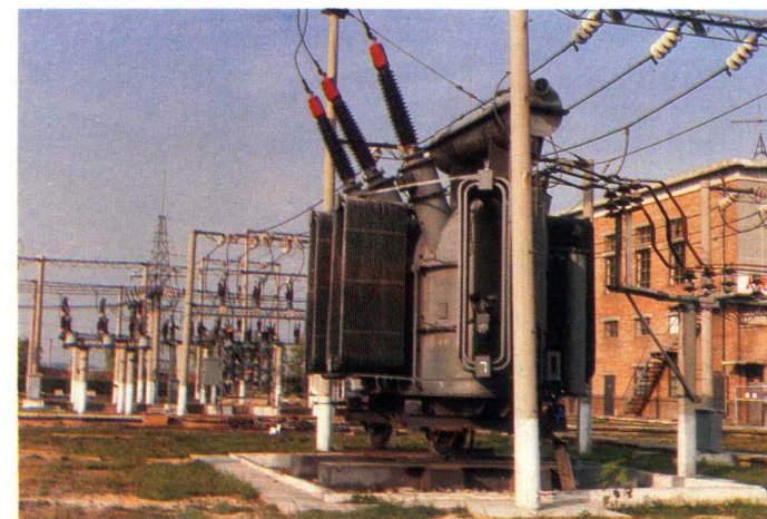
22 萬伏輸變電系統 Electricity Transmitting of 220,000 Volt 22만볼트 전기의 변압수송계통.
