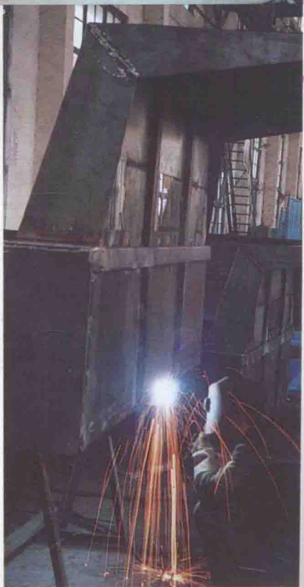
工人们正在进行 紧张有序的工作
