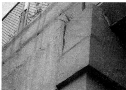
图 1-17 桥台翼墙、挡块开裂
