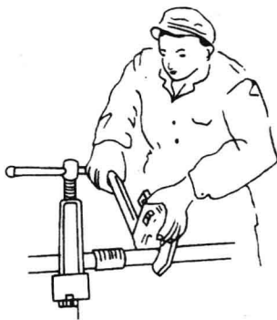
图 1-24 用管钳作管子螺纹连接
