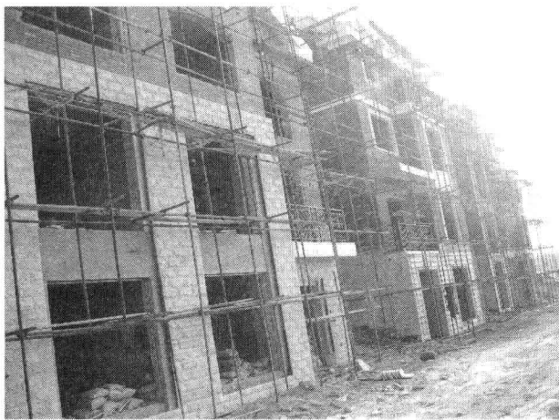
图 1-5 框架结构的实例图
