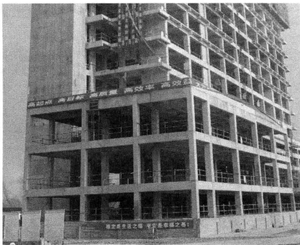
图 1-7 框架—剪力墙结构实例图
