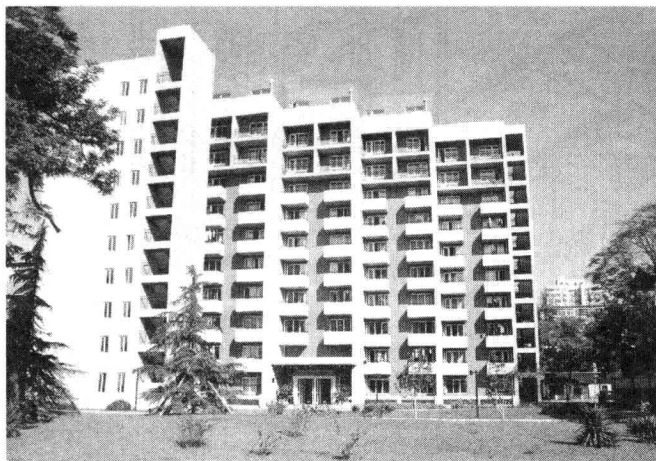
图 1-6 剪力墙结构实例图
