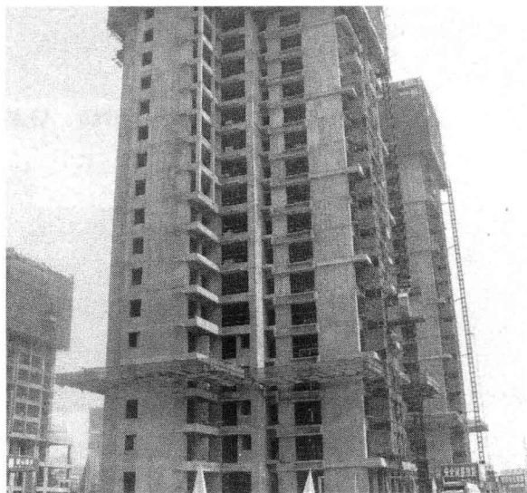
图 1-8 筒体结构实例图
