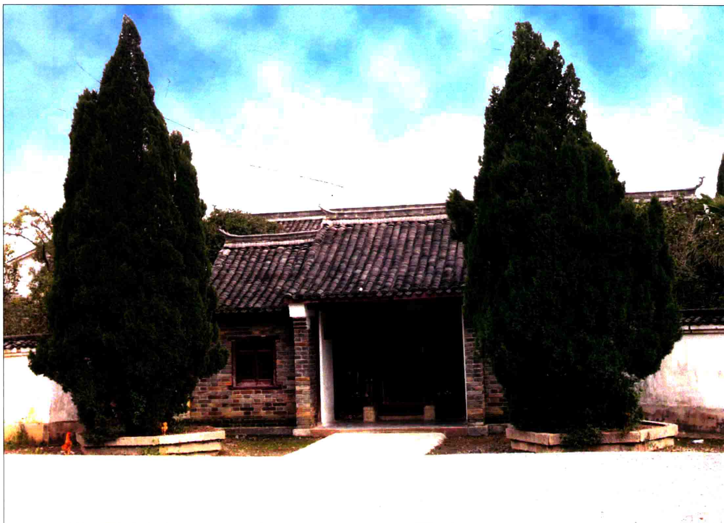
圖 1-2 修繕後的鄧石如故居（鐵硯山房），位於安慶市郊五橫鄉
