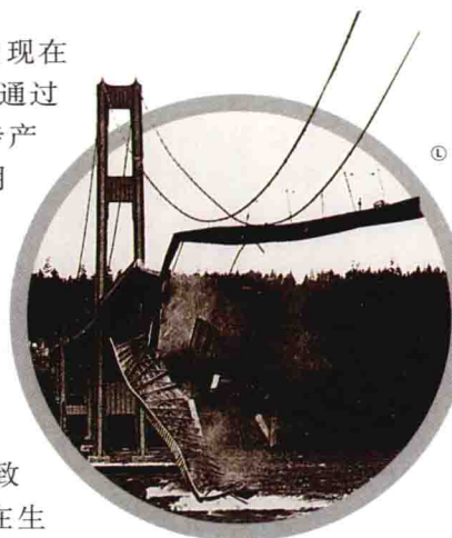
正在垮塌的塔科马海峡大桥
