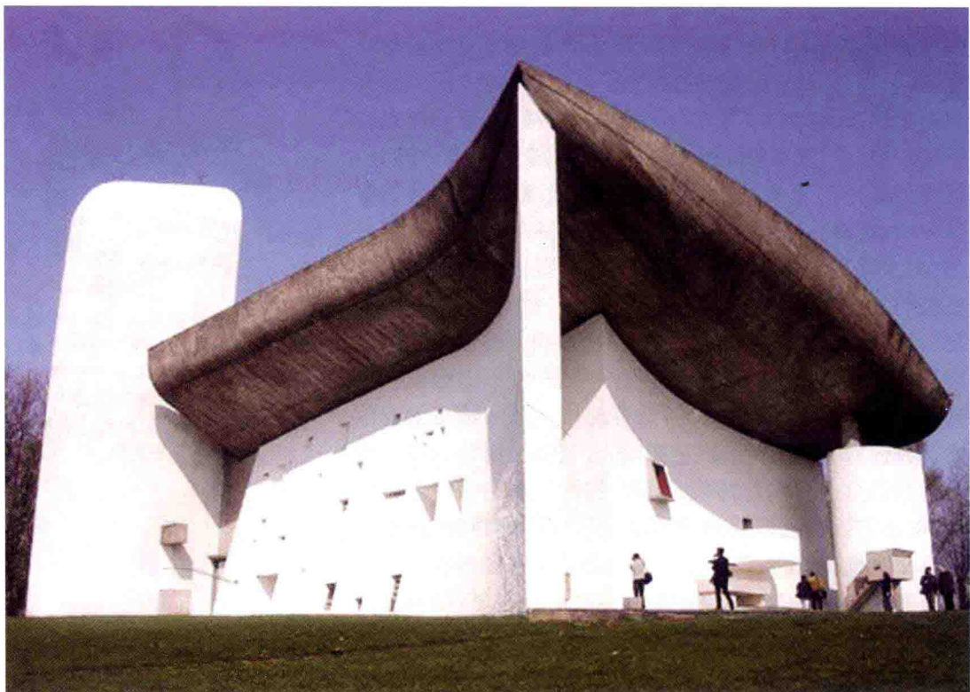
图 2-5 朗香教堂粗壮的钢筋混凝土结构,粗糙的白色水泥墙面,沉重的屋顶向上翻卷,柯布西耶(Le Corbusier)粗野的表现手法不仅令人感到新奇,更使人们意识到建筑自身的精神内涵。
