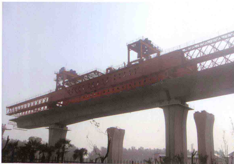
节段预制箱梁施工
