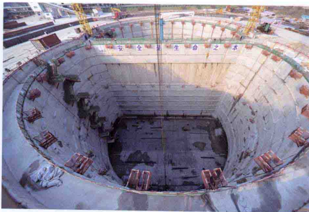
南锚碇超大地连墙施工
