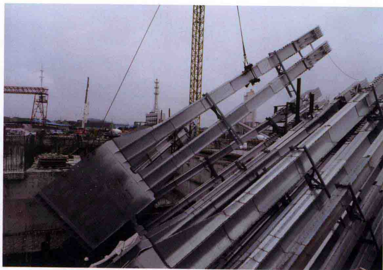
锚碇锚固钢板的接高
