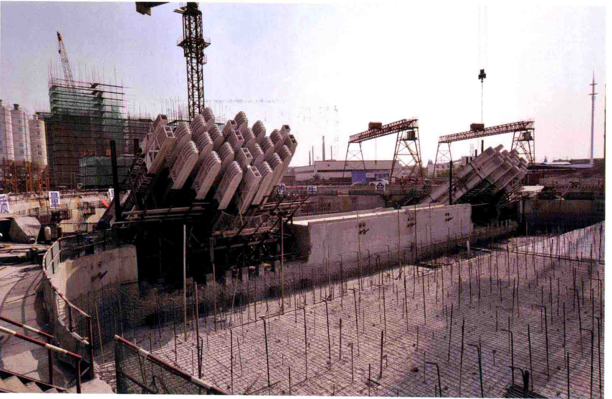
锚固体系施工
