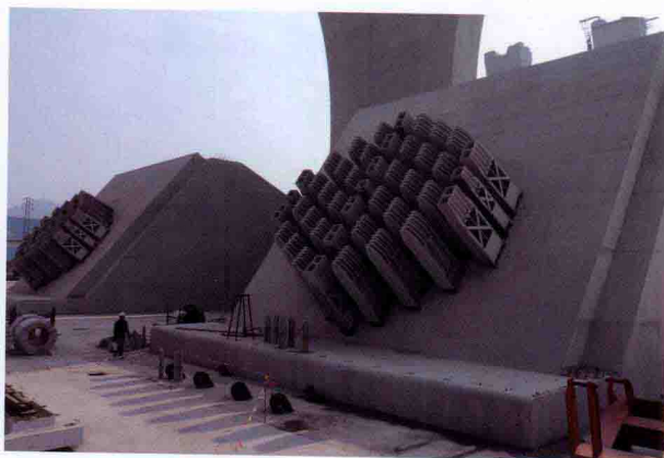
锚碇锚固钢板的接高
