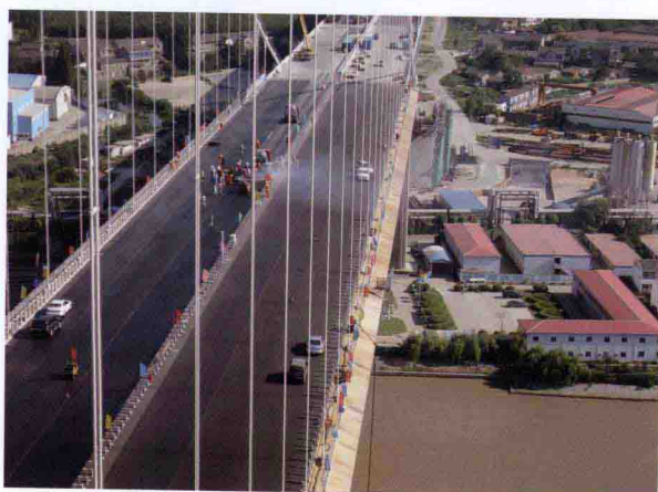
钢桥面铺装远景图
