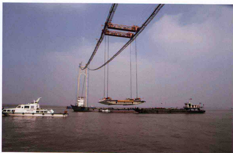
主桥钢箱梁吊装施工
