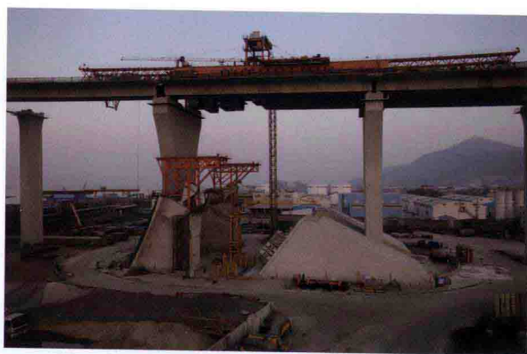
主桥锚体上方预制节段梁的吊装
