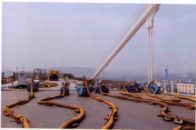
主桥钢桥面抛丸打砂施工
