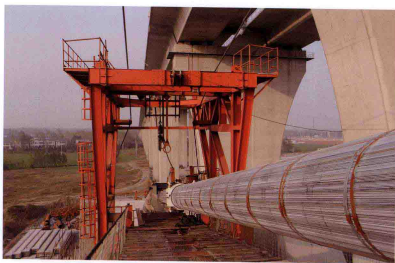
主缆紧缆施工
