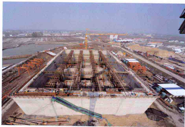
北锚碇沉井施工
