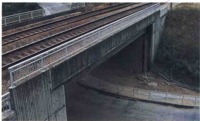
圖2.6 位於道路上空的鐵路
