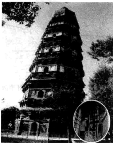
图3 虎丘塔倾斜照片
