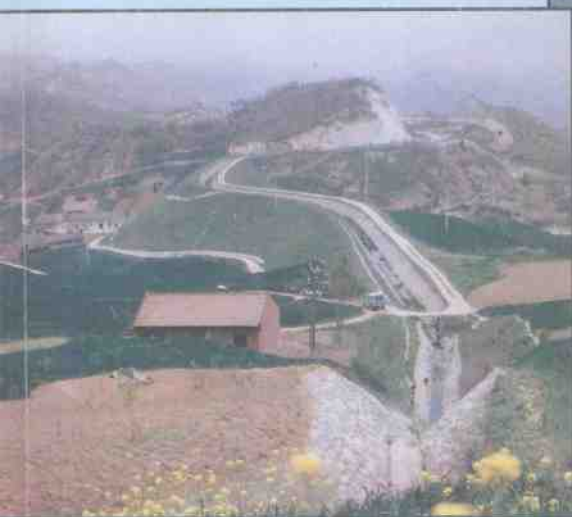
黄土岭大填方渠道
