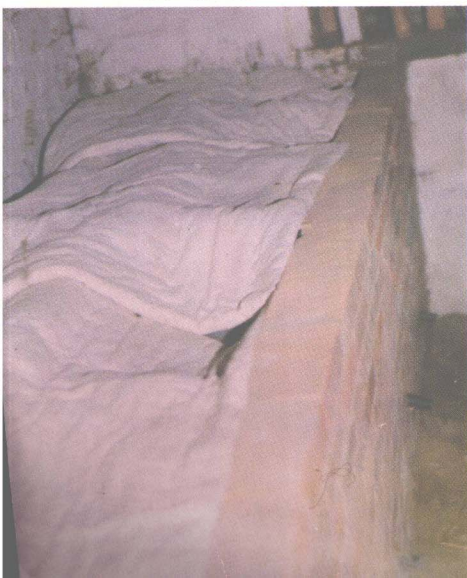
保温槽的覆盖
