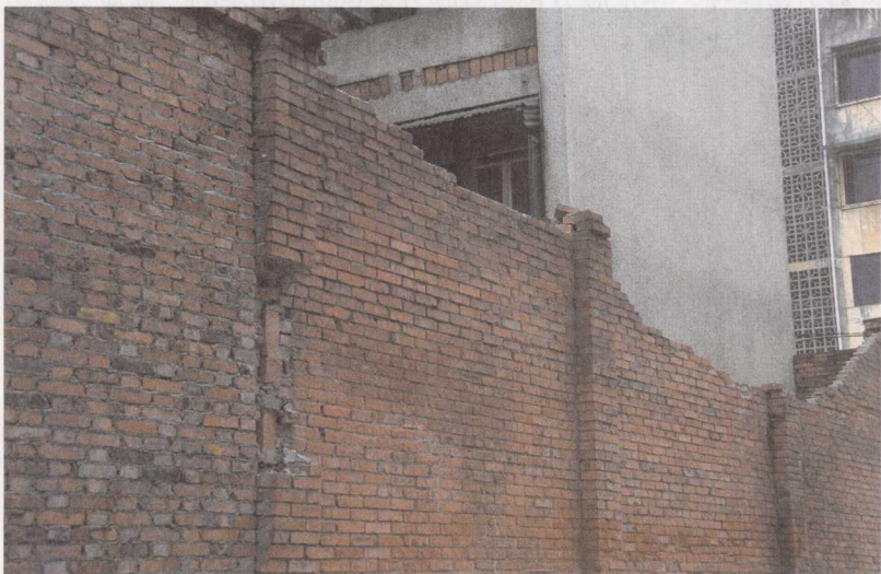
图 1-5 震区围墙的常用做法
