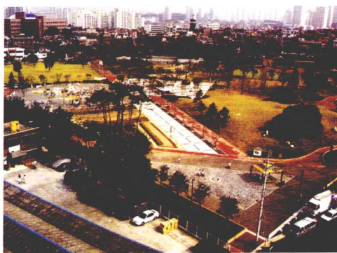
竣工后的实景照片
