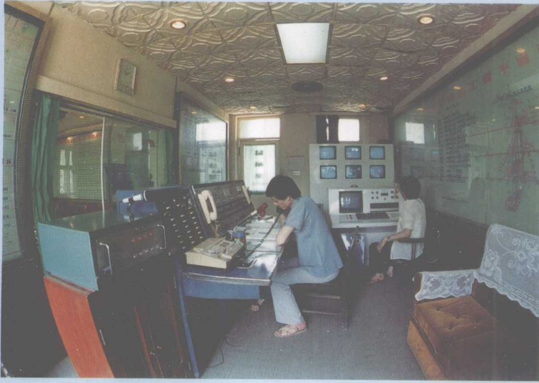
芙蓉矿务局煤矿调度室
