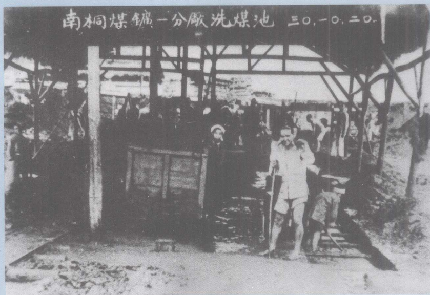
南桐煤矿洗煤池(1941年)
