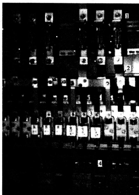
图 1-5 安装在配电盘上的电动机回路开关设备
