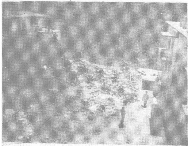
图 1.3.1 大坪区公所食堂倒塌现场
