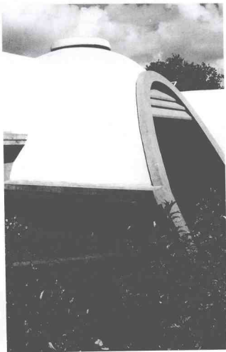
图 1-9 雷·密克(Ray Meeker)用当地的泥料在印度南部本地治里村建造泥屋。那些精巧的手工砖来自窑的拱顶及围墙,室内放置了砖、花盆、窗户通风隔扇等陶艺作品,它们都是不久前才在柴窑中烧成的。这座坚固的建筑施白漆、地面铺陶砖,一切就绪只待入住。除了稀有和珍贵的木材外,眼下密克正在作其他燃料实验,比如将可燃物与砖混合
