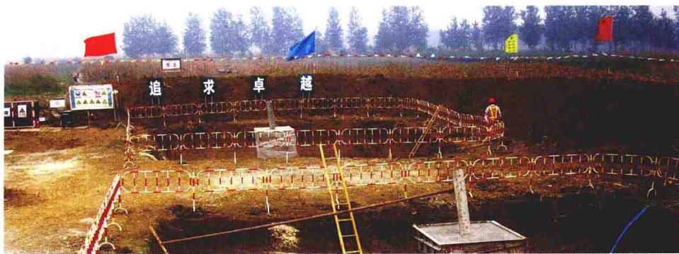
图1-2-6 土石方堆放实例图
