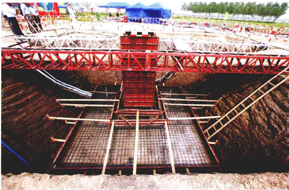
图1-2-4 大板式基础施工布置实例图
