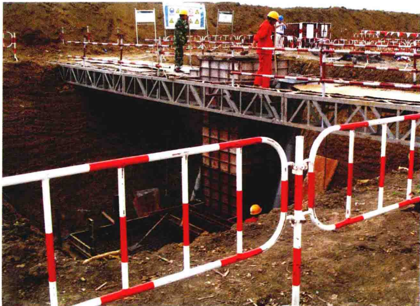
图1-2-1 板式基础施工现场实例图
