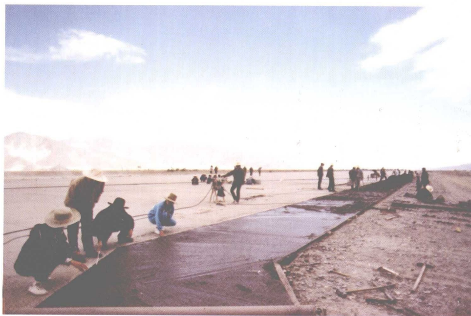
1992年，贡嘎机场第一次扩建工程中的机场跑道道面施工场景。
