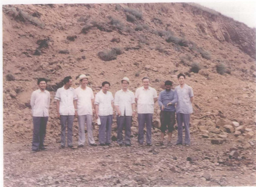
大秦铁路云冈支线马武山爆破现场 (左二为杨友成，左四为 马鸿臣 ，右五为何广沂)
