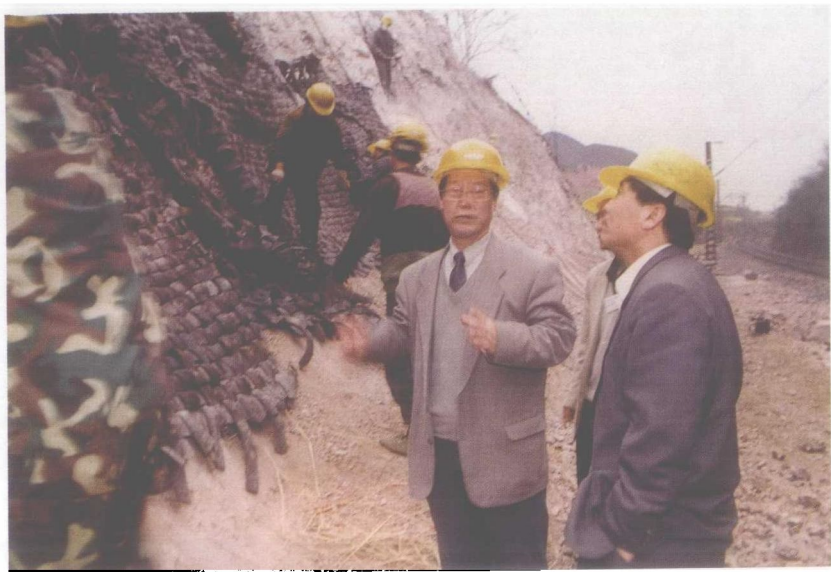
株六电气化铁路石方控制爆破覆盖“炮被” (中间为作者，右为王兆友)
