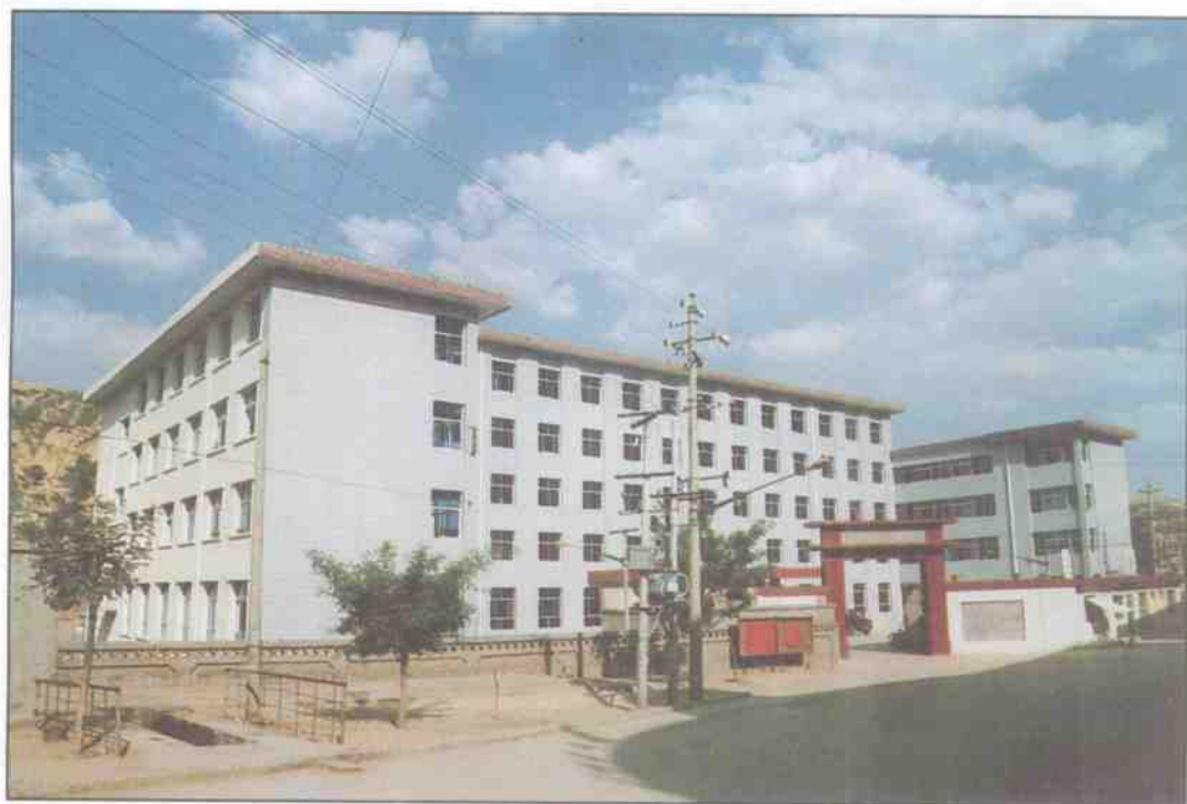
延川县人民政府办公楼
