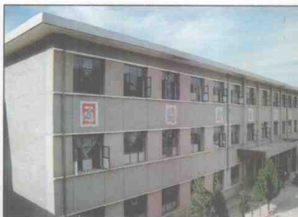
延川中学教学楼
